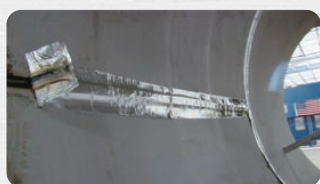
ファイバーガラス製テープが ルートギャップを裏側からカバー
